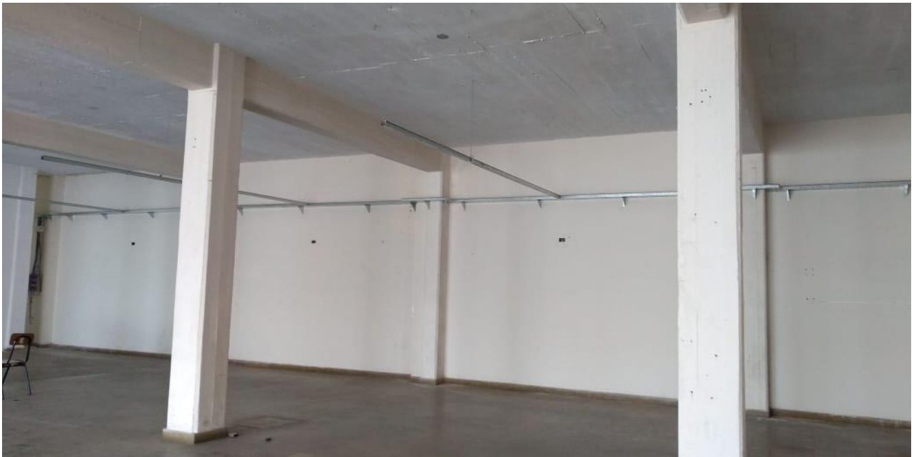
Avances en canalización eléctrica de la zona donde se instalará el Club Social de Innovación, frente al sector del PiT
